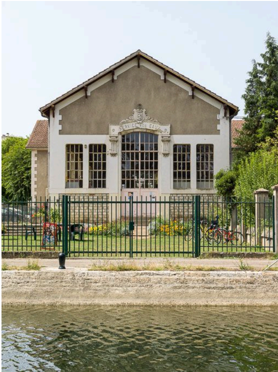
Le bâtiment du moulin : de face.
