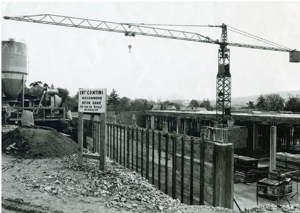
Chantier de construction de l'usine B, fotogr., 1961.
