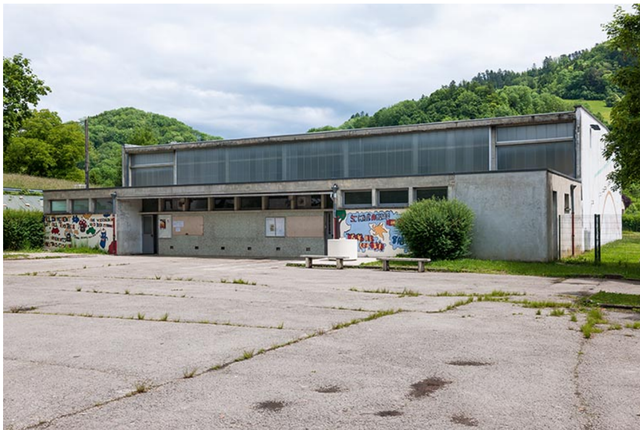
Façade antérieure du gymnase.
