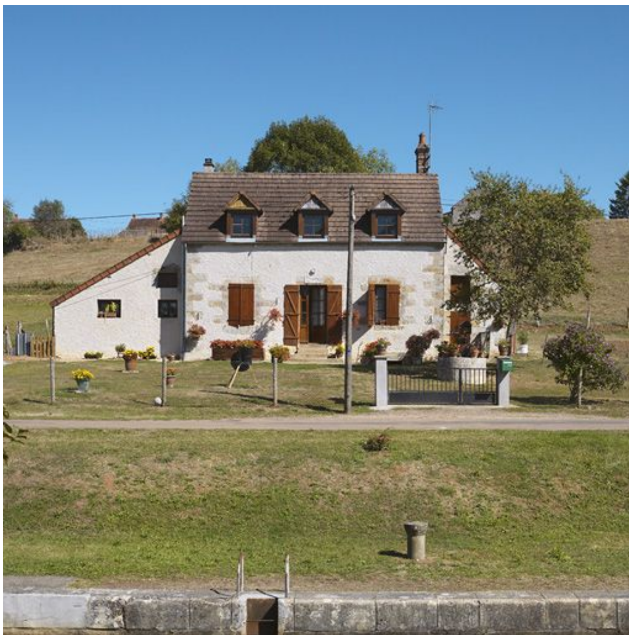
La maison éclusière, de face.
