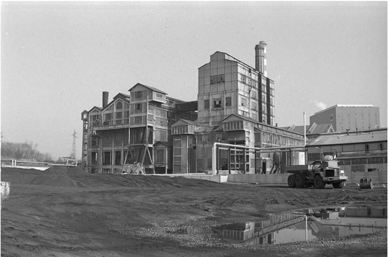
Les chaufferies, pignons sud.
