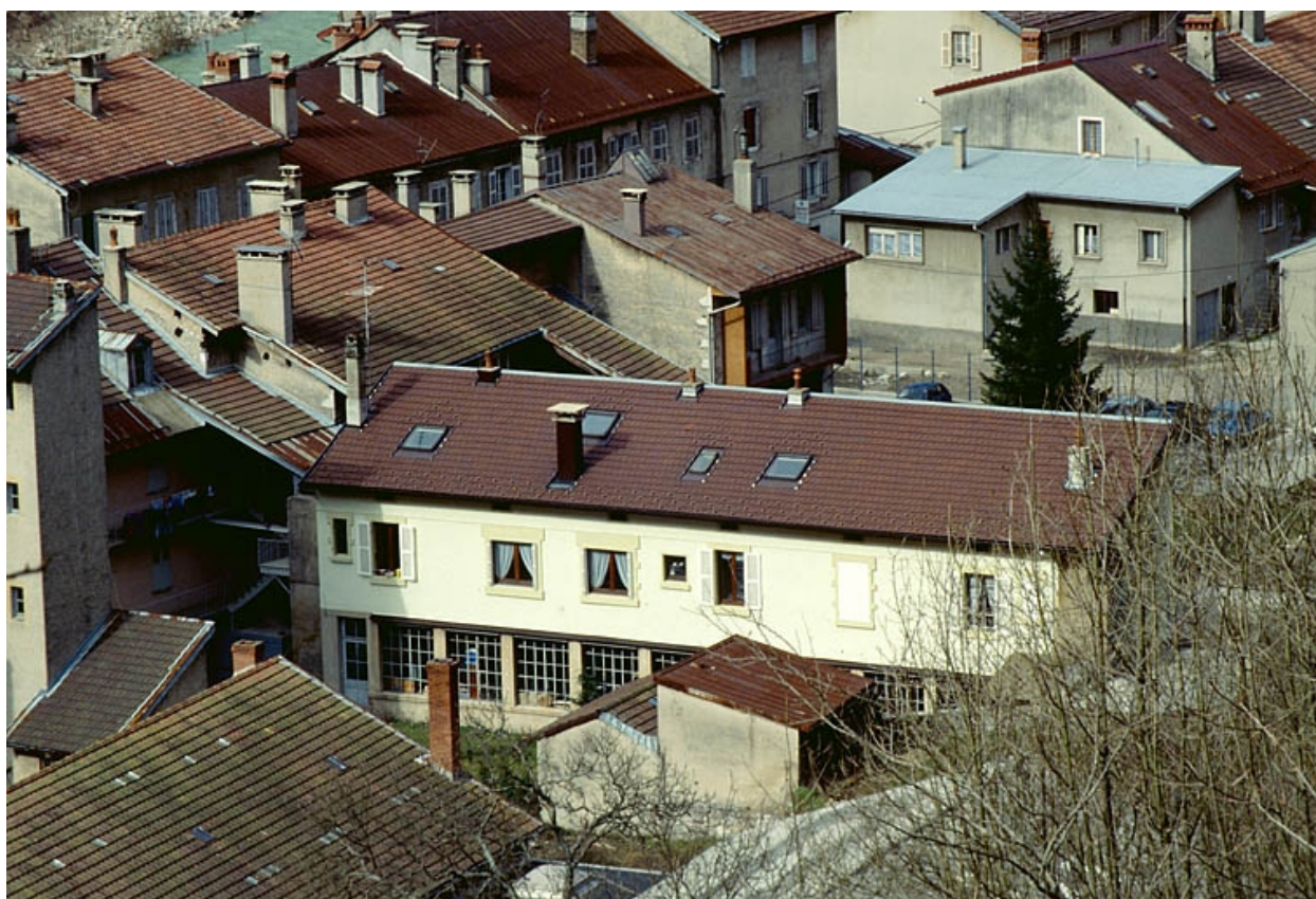
Vue plongeante sur l'atelier de fabrication.
