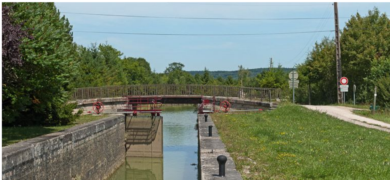
Vue du pont depuis l'amont.
