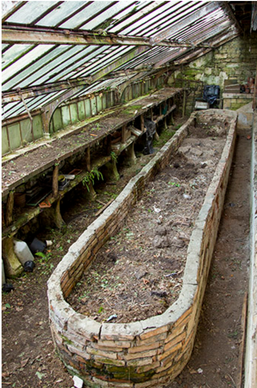
Intérieur de la serre accolée à la façade sud.
