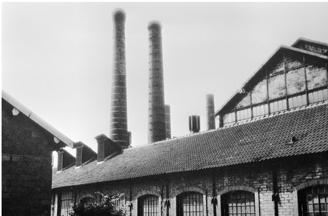
Façade postérieure du bâtiment des compresseurs.
