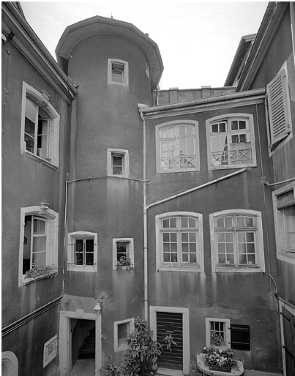
Galleries de liaison et tour d'escalier.
