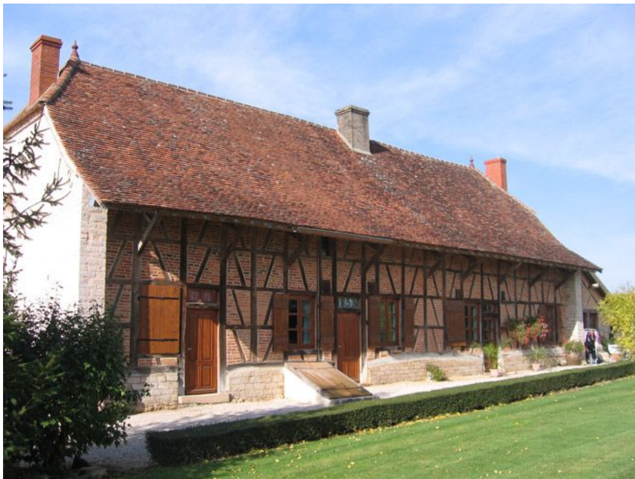
Vue d'ensemble de la façade de l'habitation.
