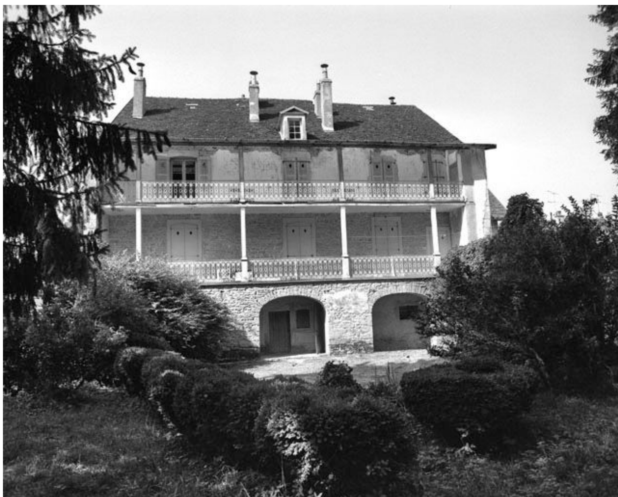
Façade postérieure vue de face.
