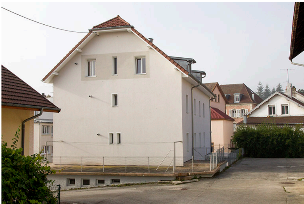
Bâtiment nord : façades latérale droite et postérieure.
