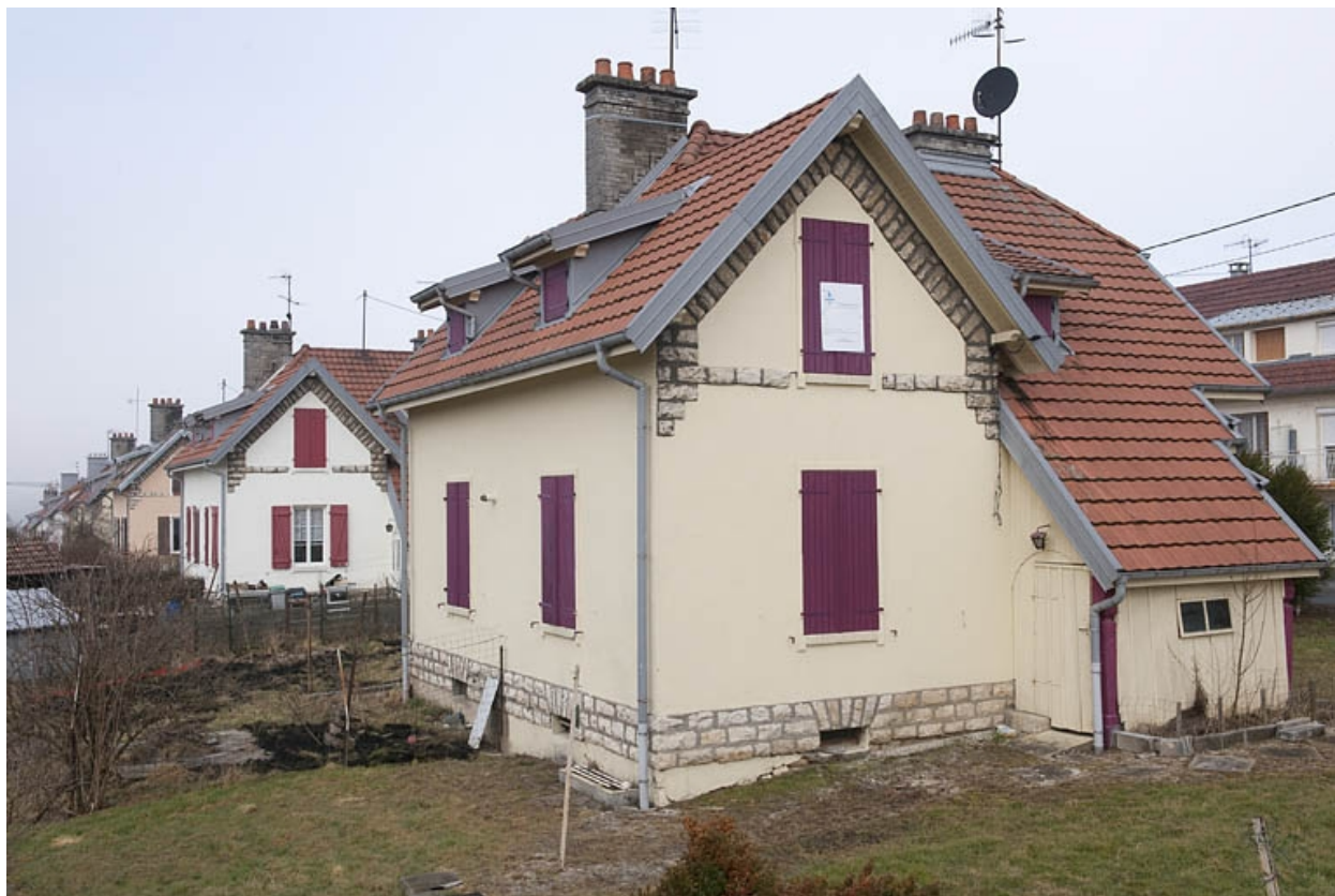
Façades sud des maisons jumelées impasse Bellevue.
