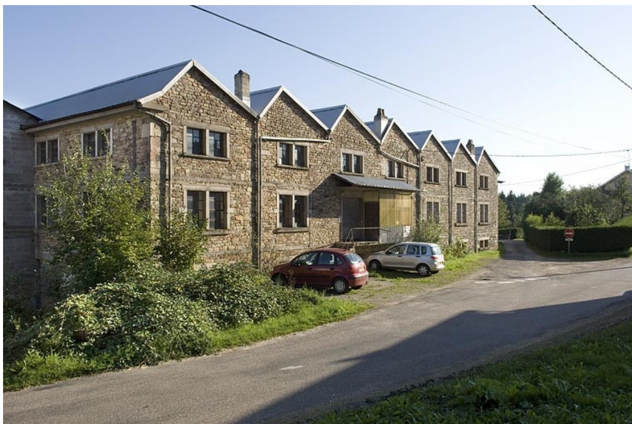
Pignons antérieurs depuis le nord.
