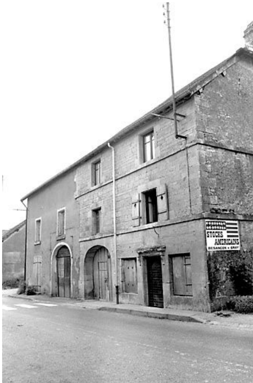
Maison située 4 Grande Rue.
