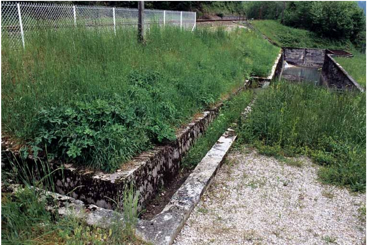
Canal reliant l'aqueduc au réservoir.
