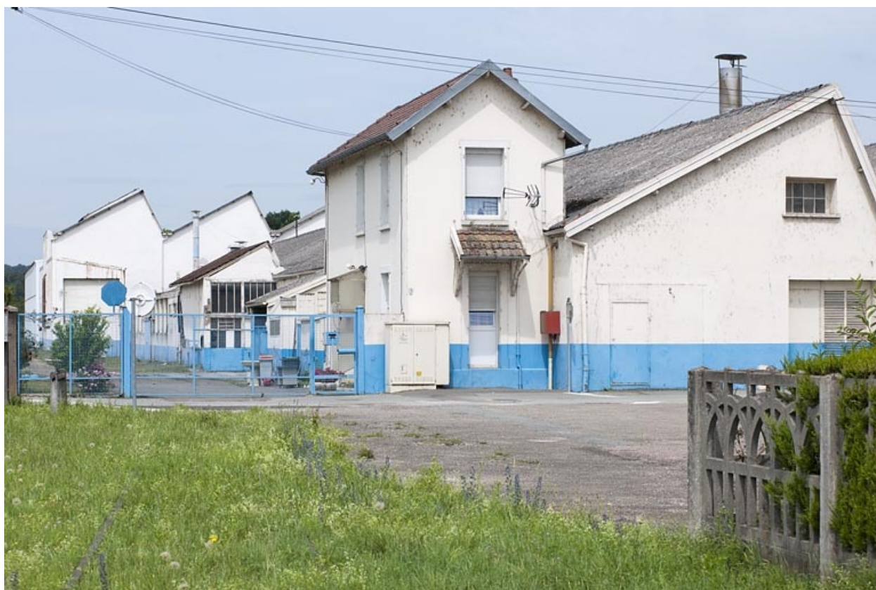
Bâtiments sud et conciergerie depuis le sud-est.
