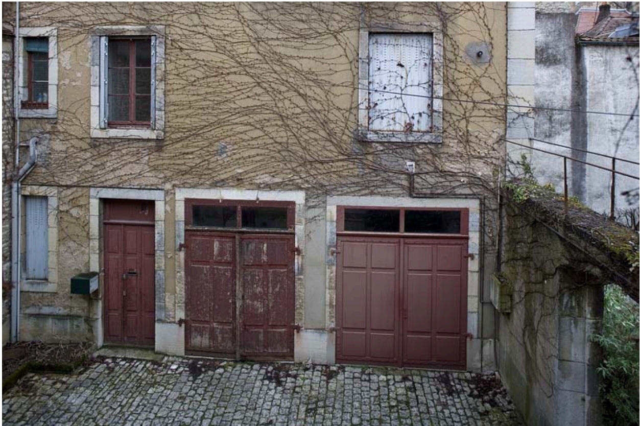
Détail du rez-de-chaussée des communs, à droite de la deuxième cour.
