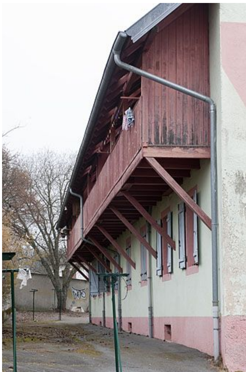
Façade postérieure de l'immeuble de 10 logements.
