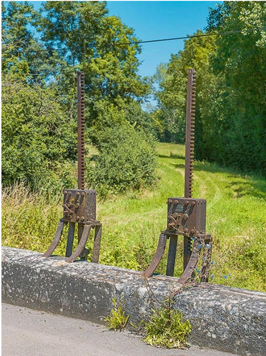
Détail des deux vannes du ponceau.
