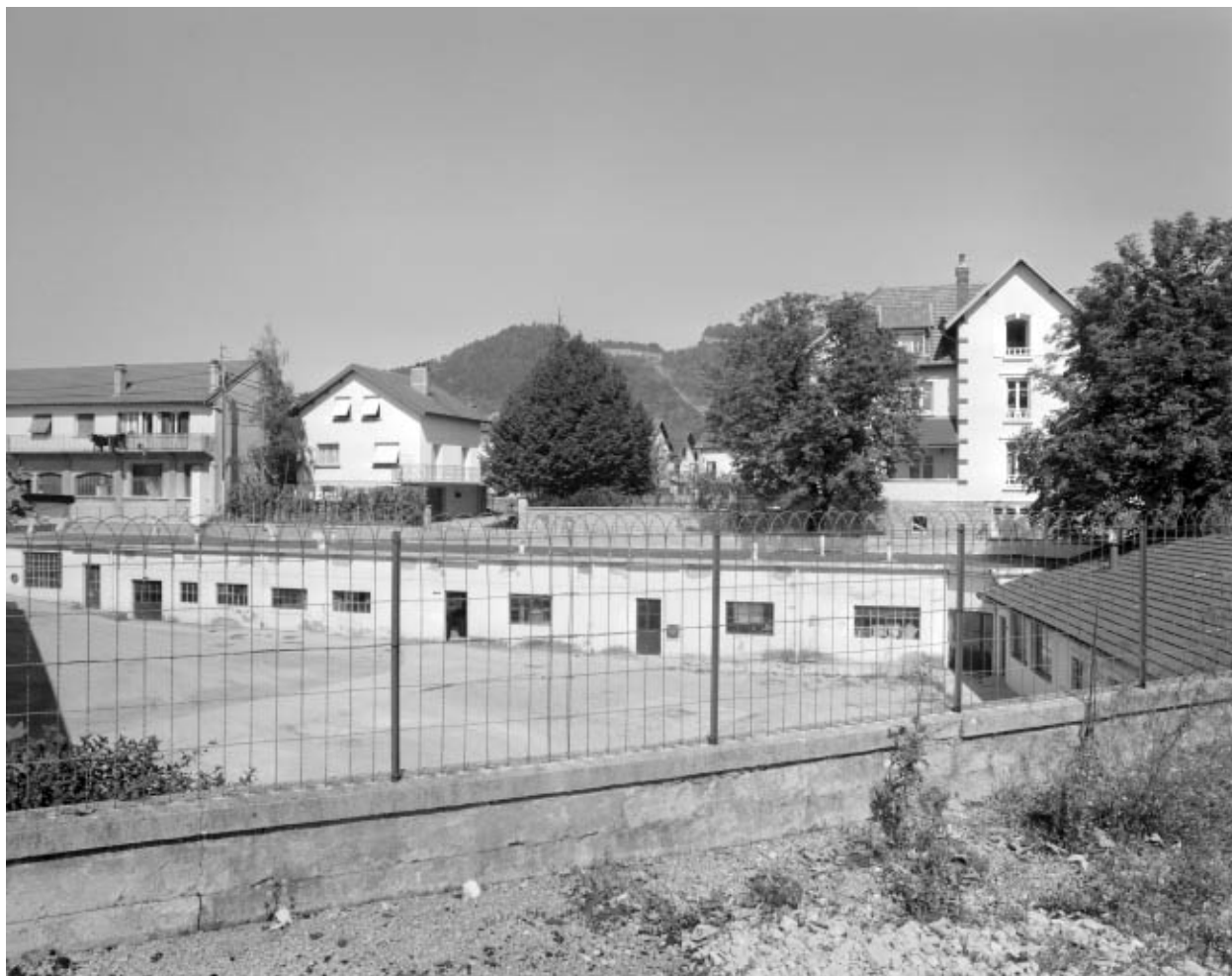
Atelier de fabrication (décapage).
