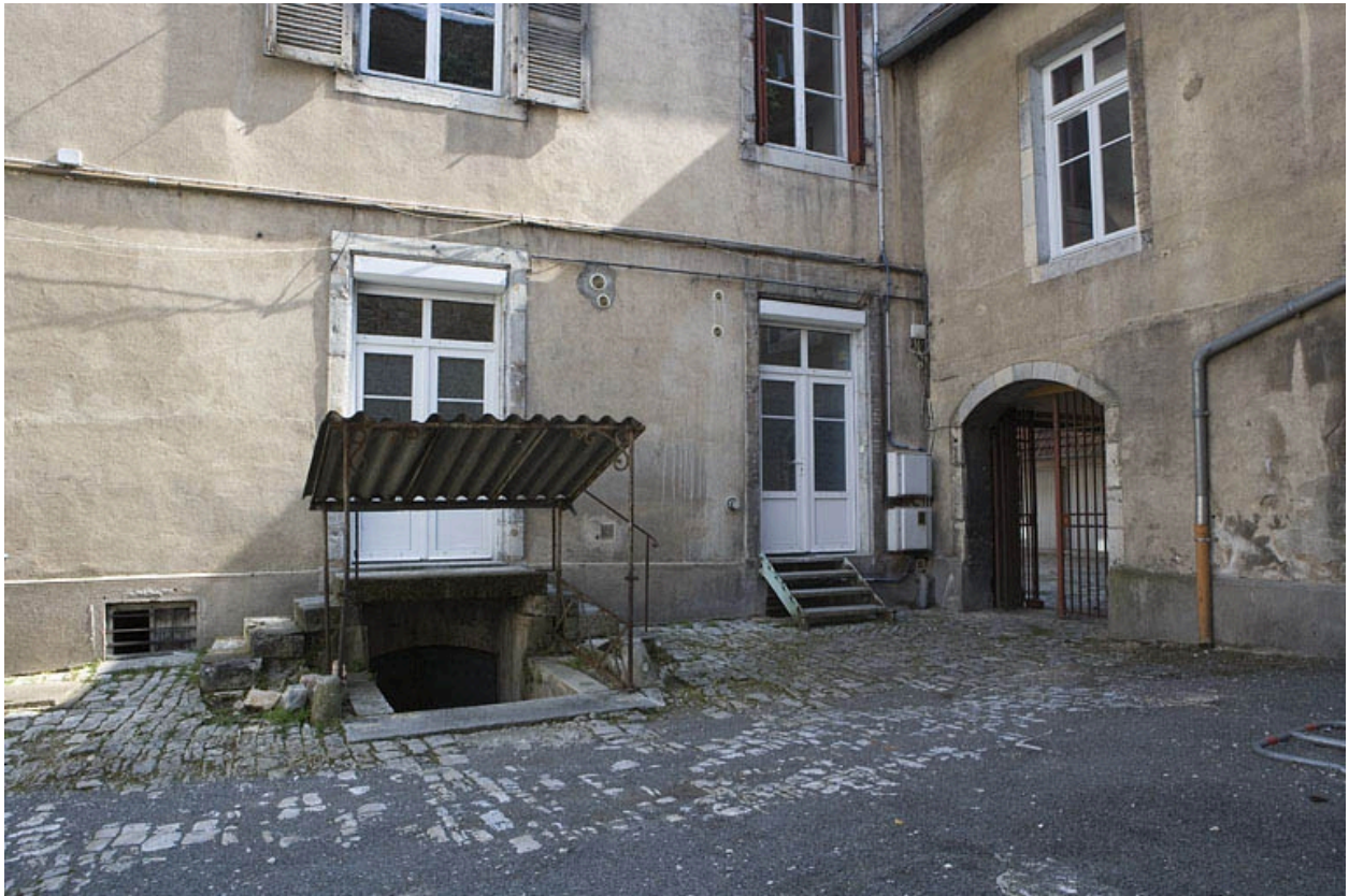
Cour secondaire donnant rue Ronchaux : détail d'une entrée de cave.
