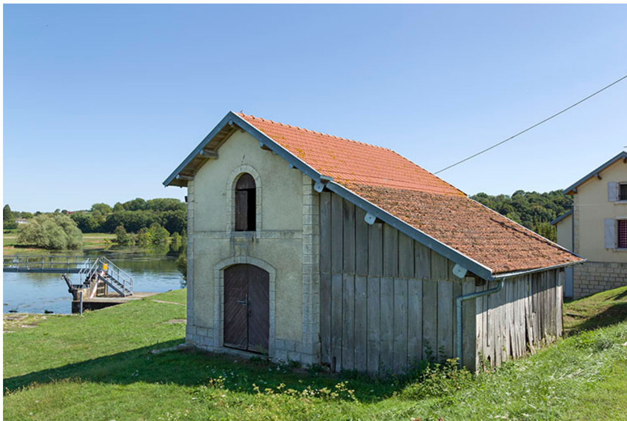
Magasin à aiguilles du barrage.
