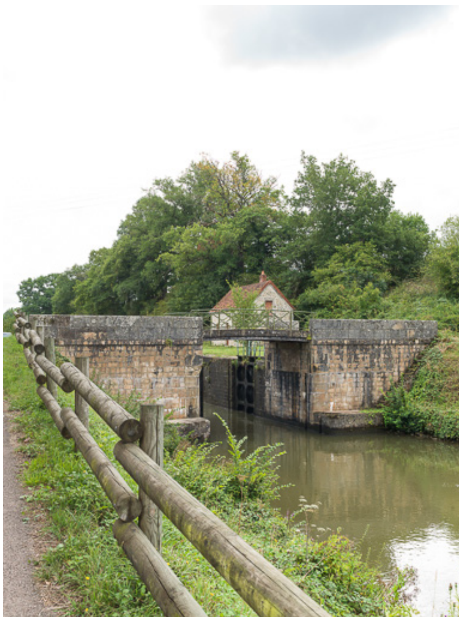
Vue d'ensemble du pont.
