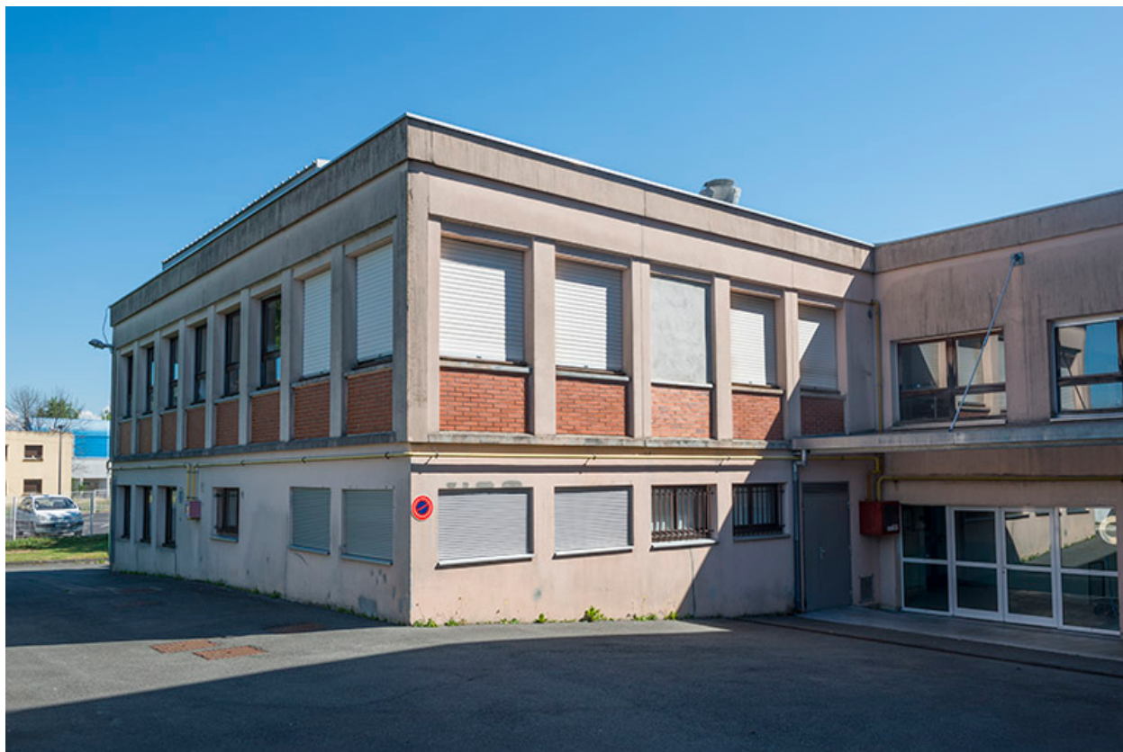
Façade ouest du bâtiment d'externat. (ex-Garnier)
