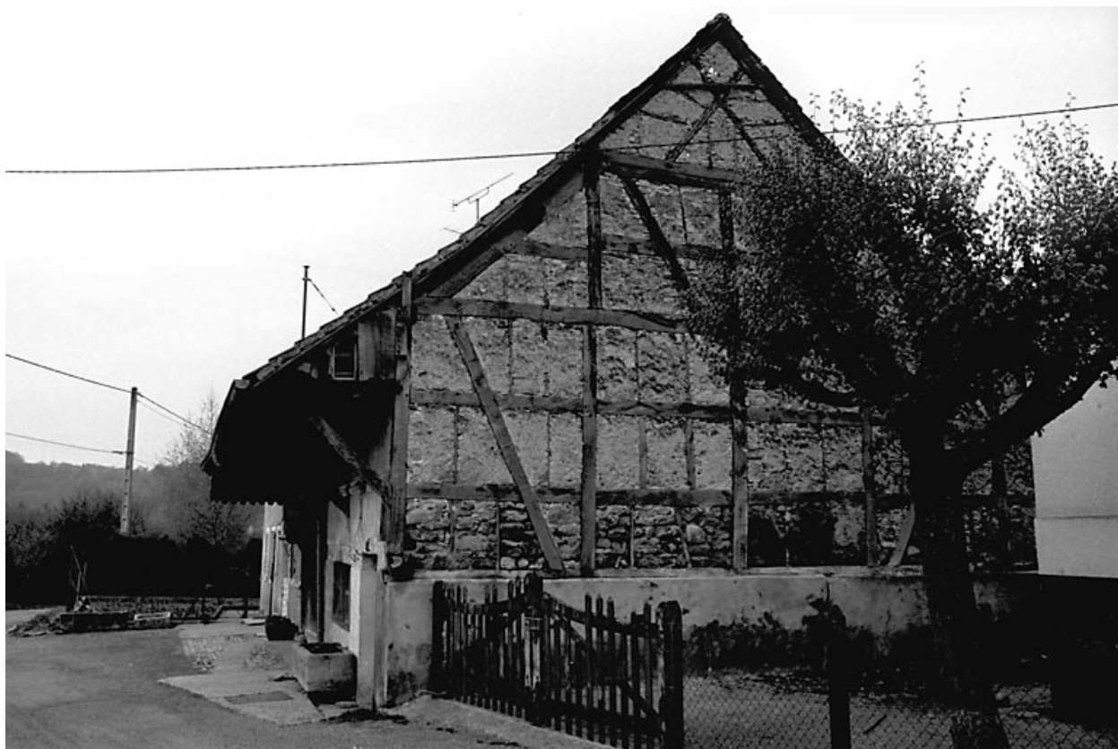
Vue du pignon droit.
