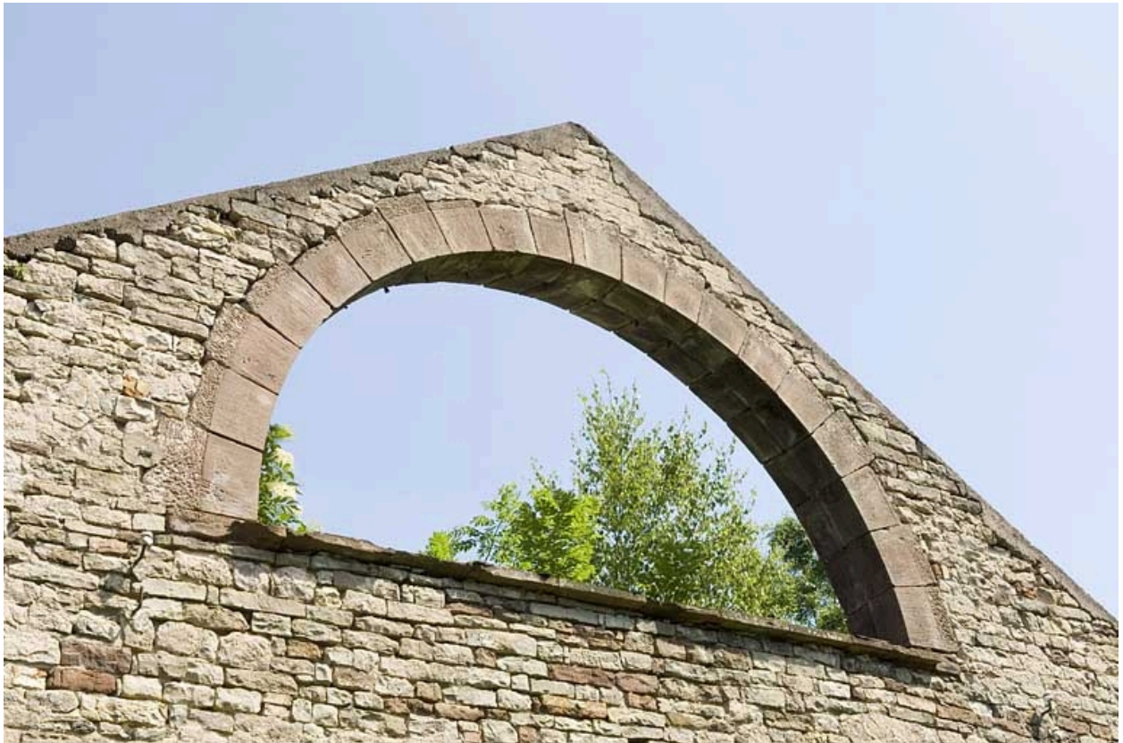
Atelier du laminoir. Baie du pignon ouest.
