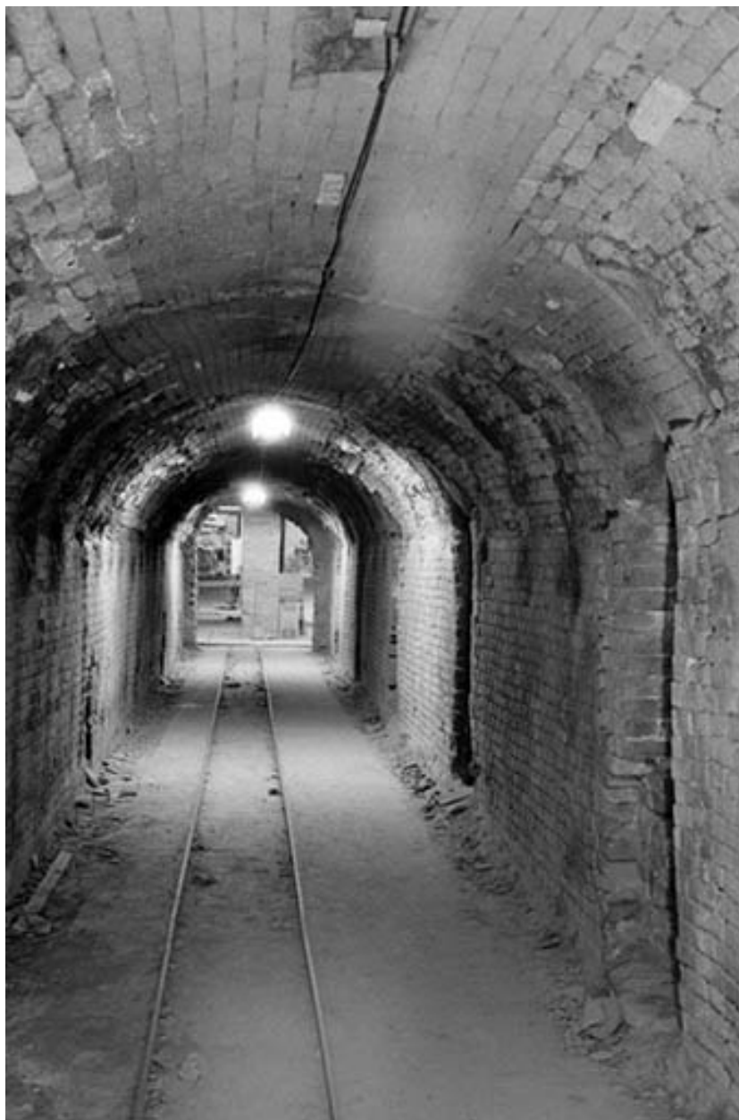
Briqueterie et tuilerie Emile Jacob, Commenailles : ancien four Hoffmann.
