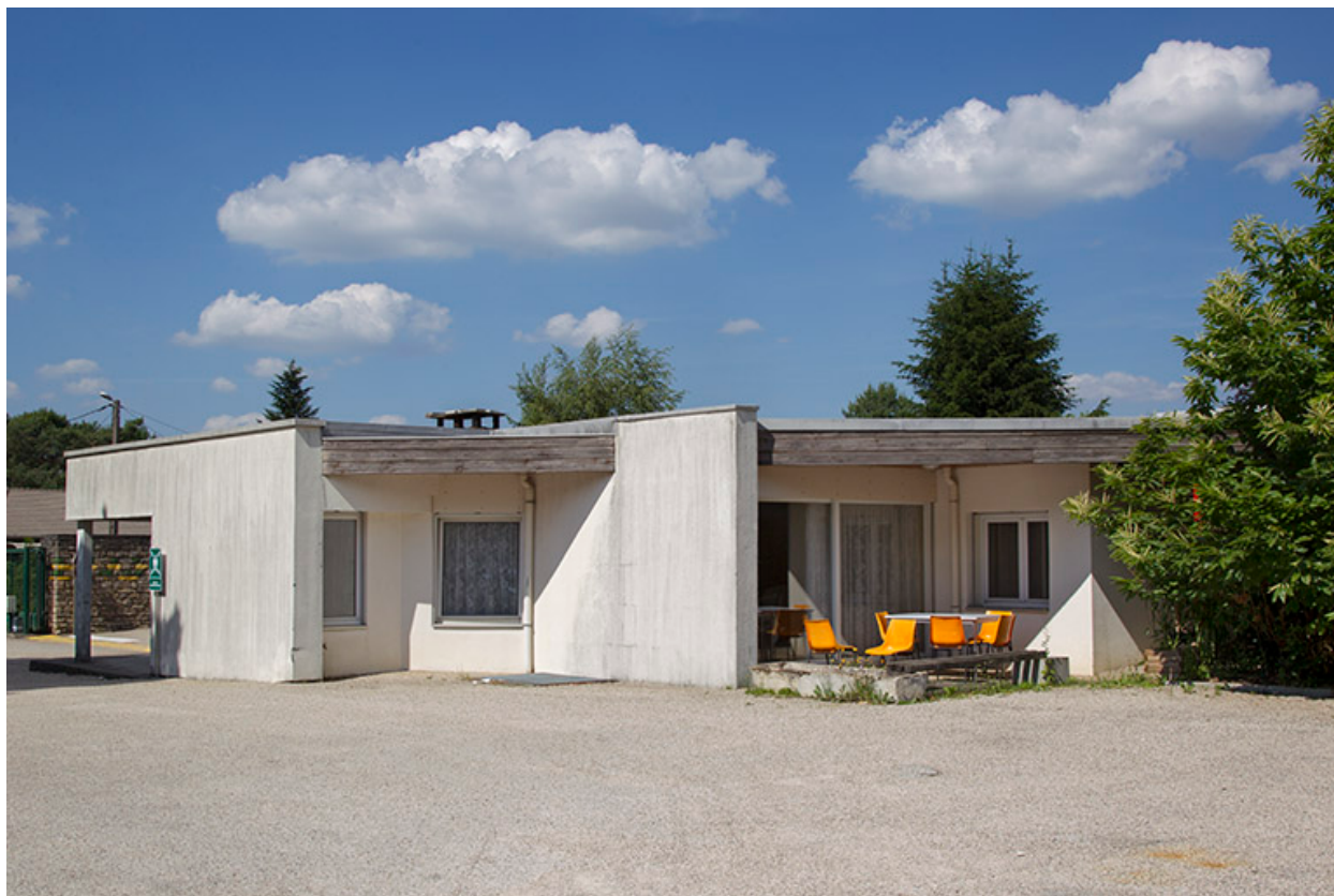
Façade postérieure ouest de la loge.
