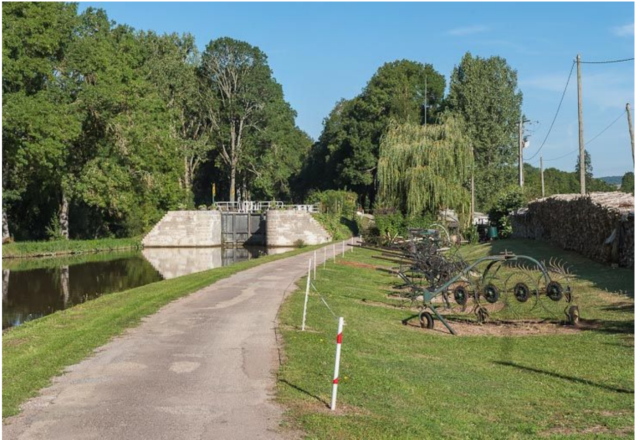
Vue rapprochée de l'écluse depuis l'aval.
