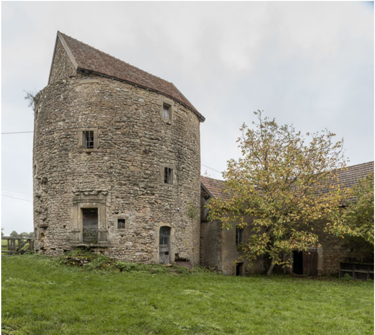
Vue de la tour de Chassagne, depuis le sud-ouest
