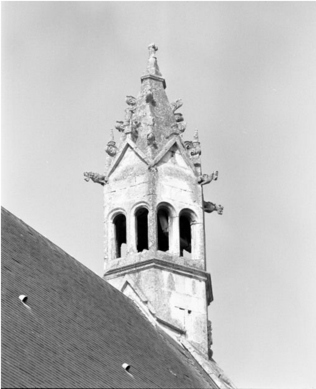
Chapelle de l'ancien château : clocheton, vue du sud-est.
