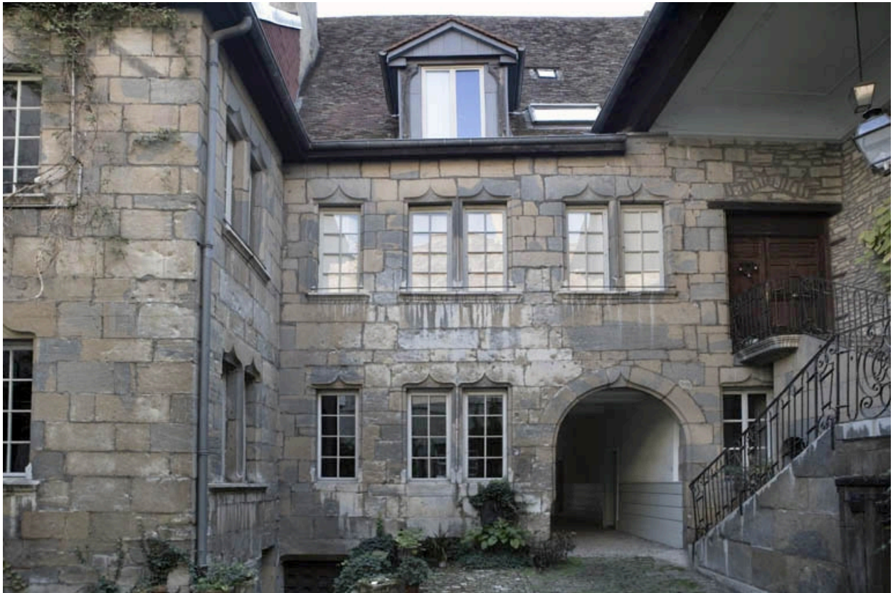
Façade postérieure du logis, de face.
