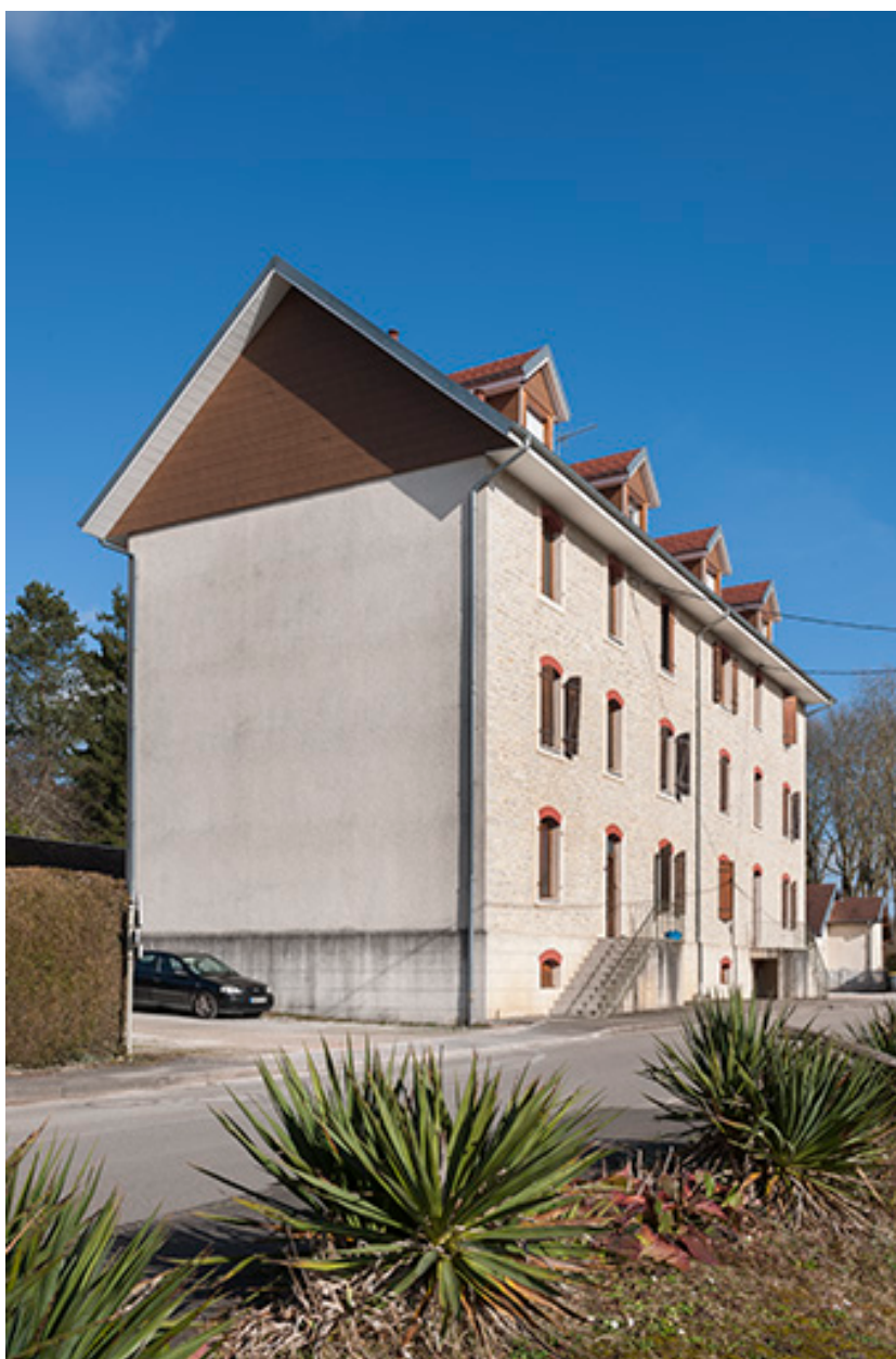
Immeuble de logements. Vue d'ensemble.
