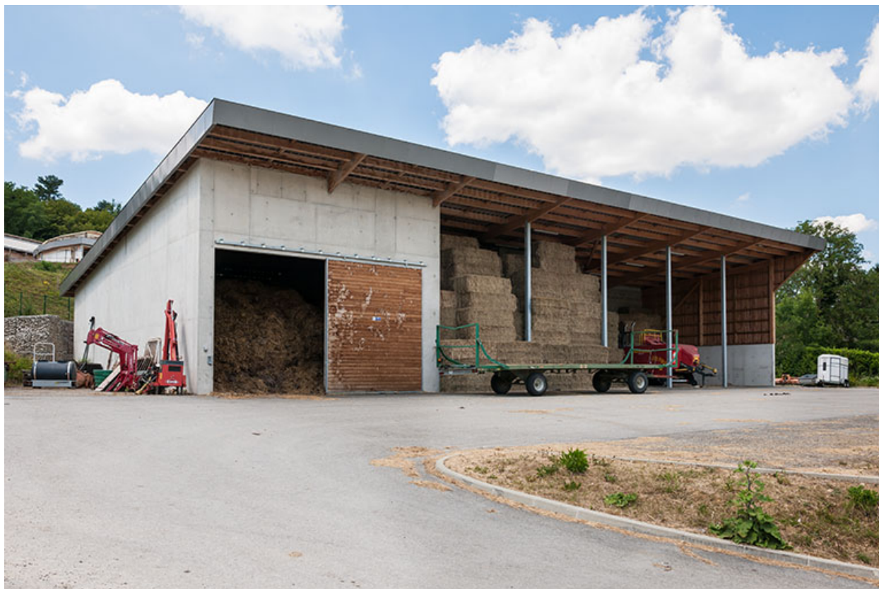
Centre équestre : hangar à fourrage.
