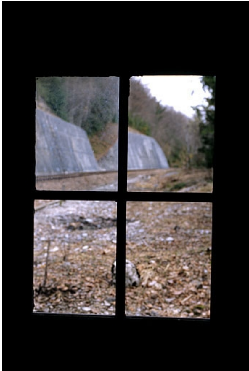
Murs de soutènement à droite de la voie, depuis l'intérieur de l'abri ancien.
