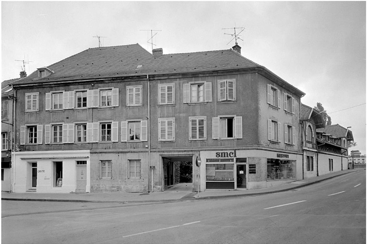
Vue d'ensemble des façades sur rue.
