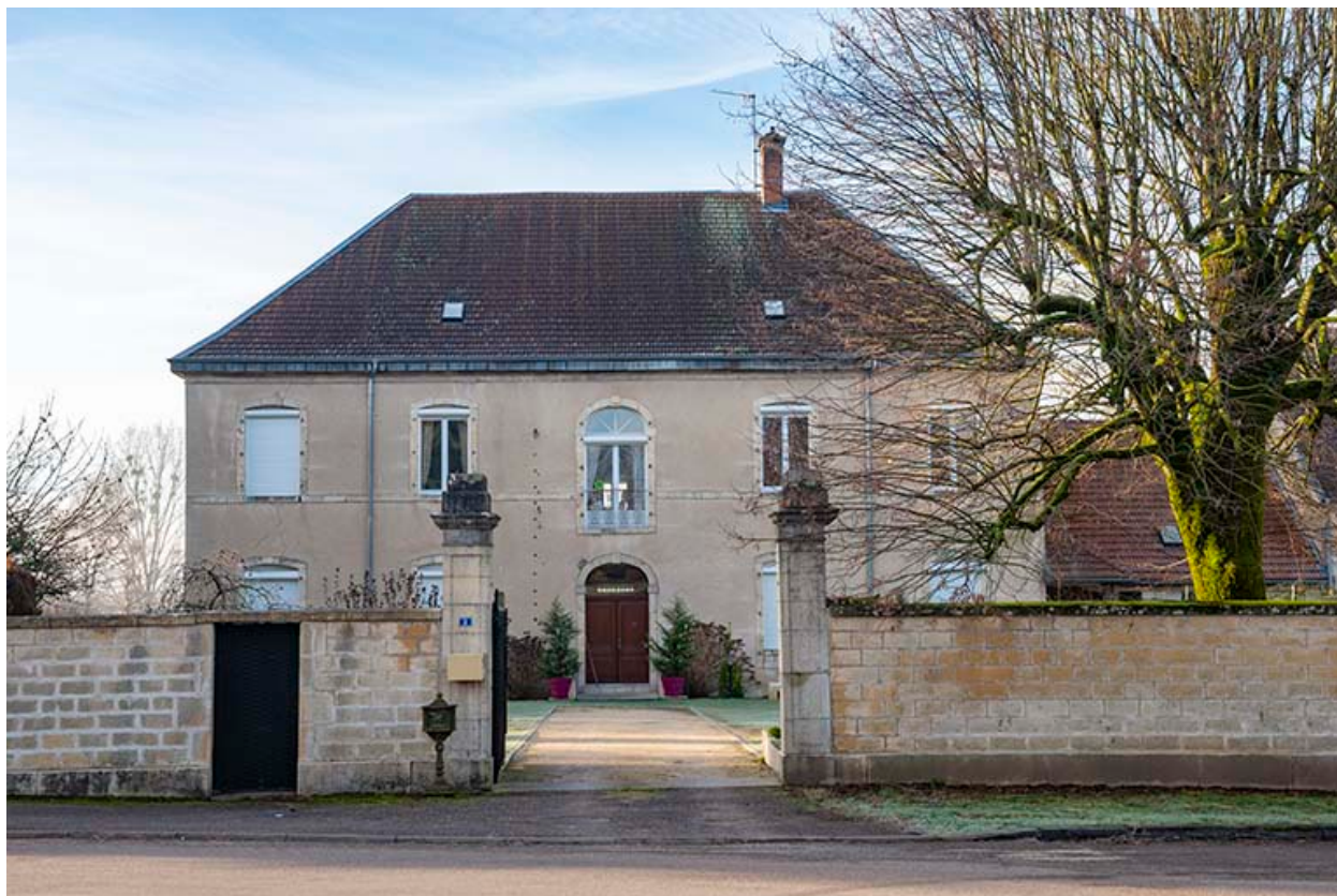
La façade antérieure et le portail d'entrée.
