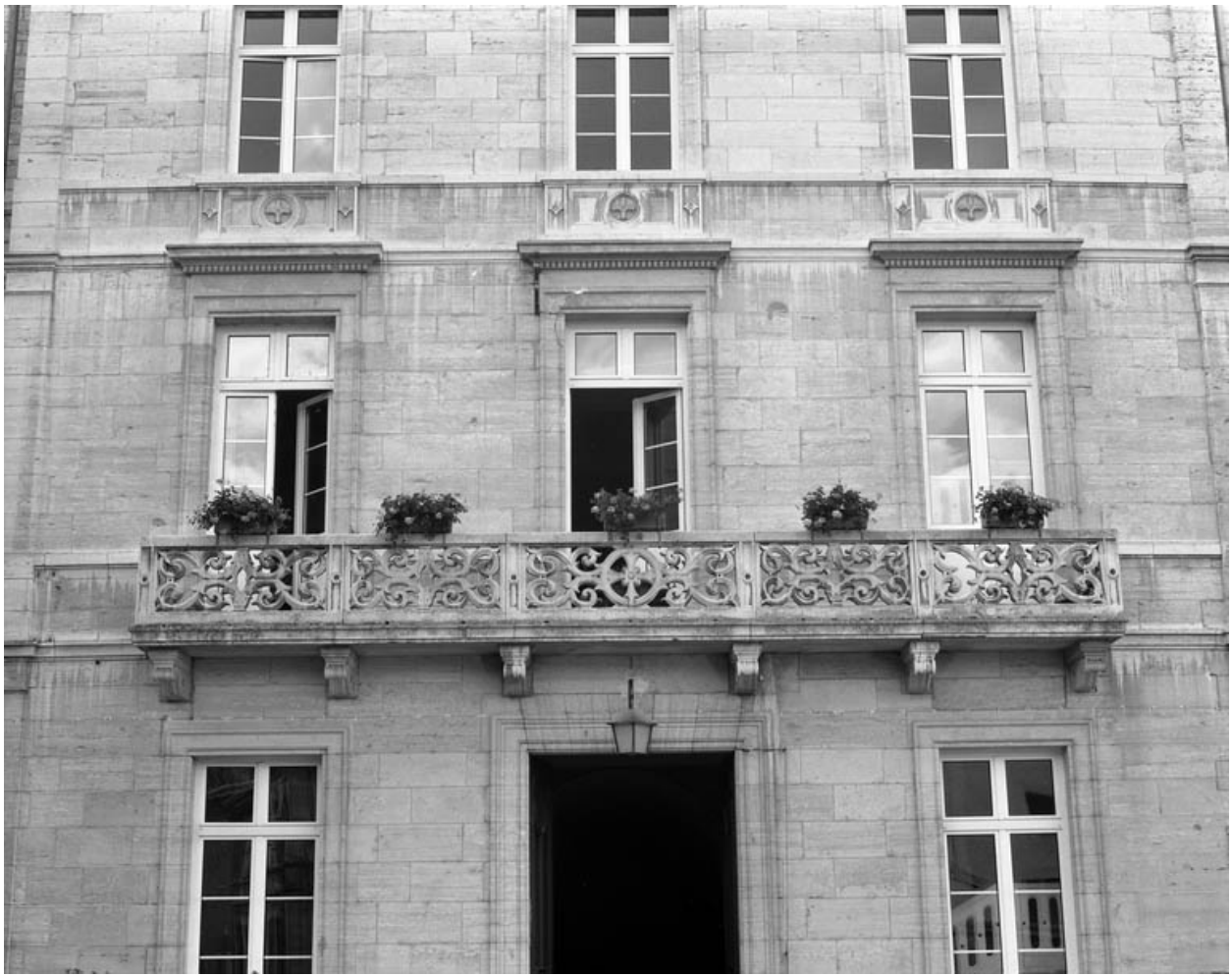
Façade principale : détail des baies du premier étage de l'avant-corps central.
