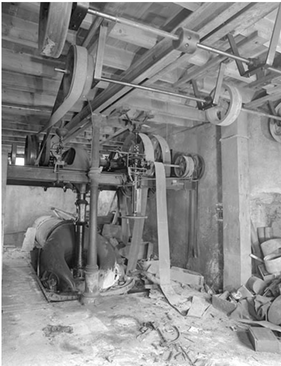
Bâtiment d'eau : bête de la turbine et transmission.
