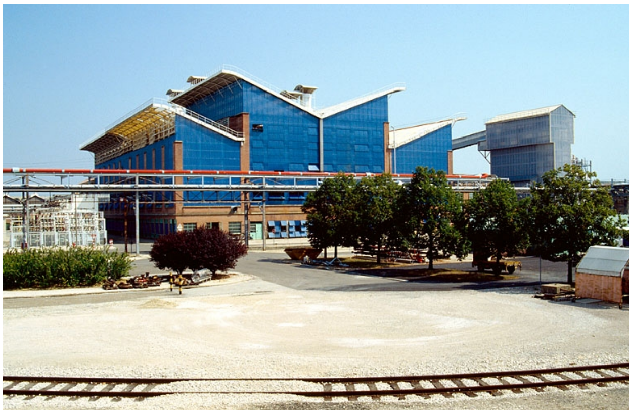
Usine d'électrolyse (37) vue du sud.
