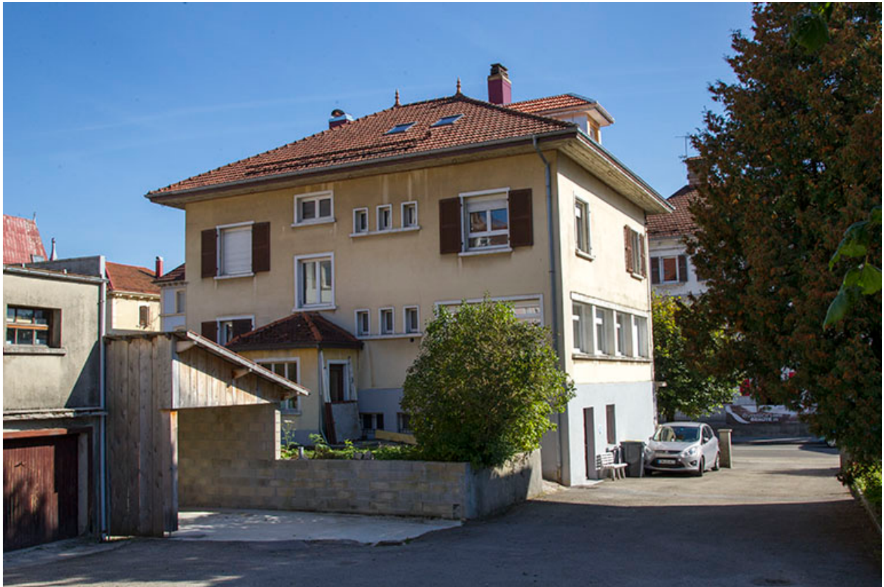
Façades postérieure et latérale gauche.
