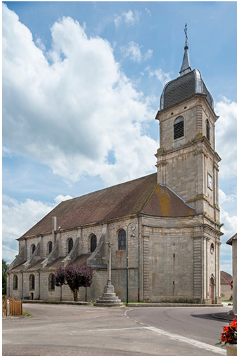
Vue d'ensemble depuis la rue de la Croix de Pierre.
