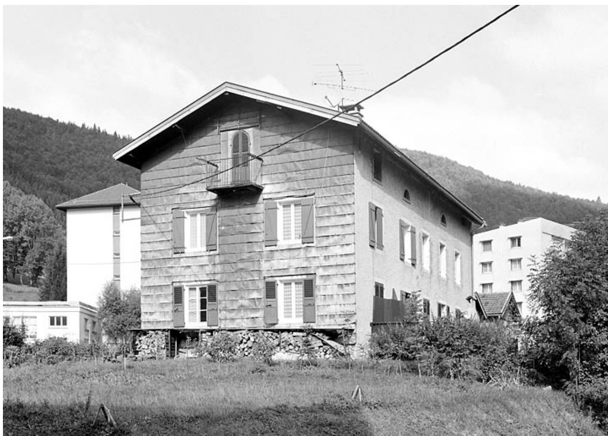
Façades postérieure et latérale droite.
