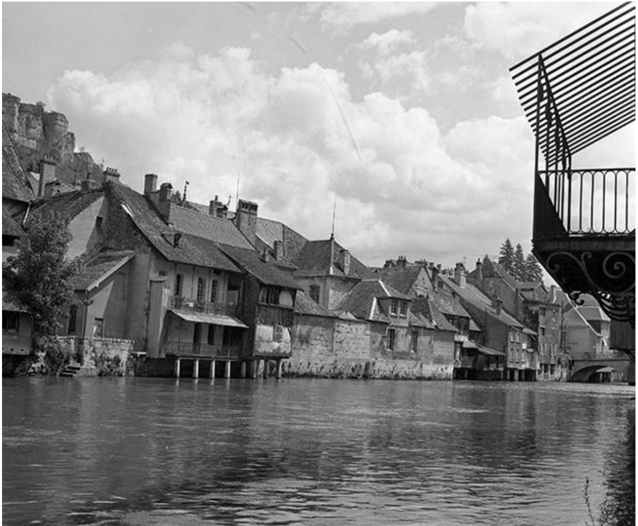
Façades postérieures des maisons de la rue Pierre-Vernier depuis la passerelle.
