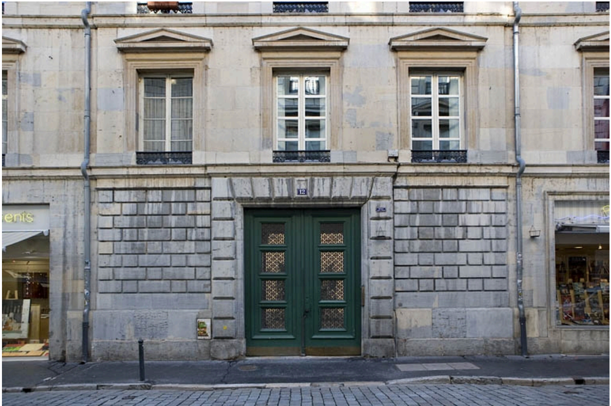
Détail du portail d'entrée, de face.
