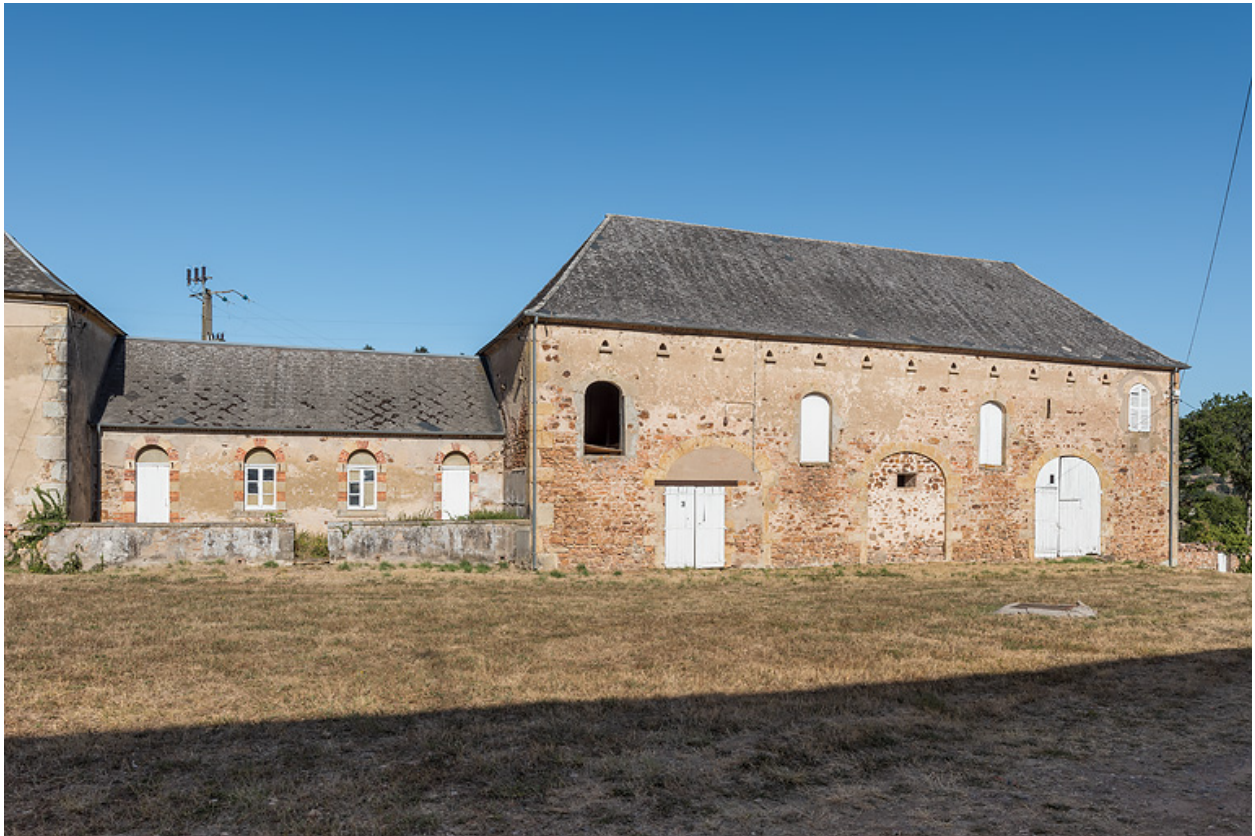
Bâtiment des dépendances.
