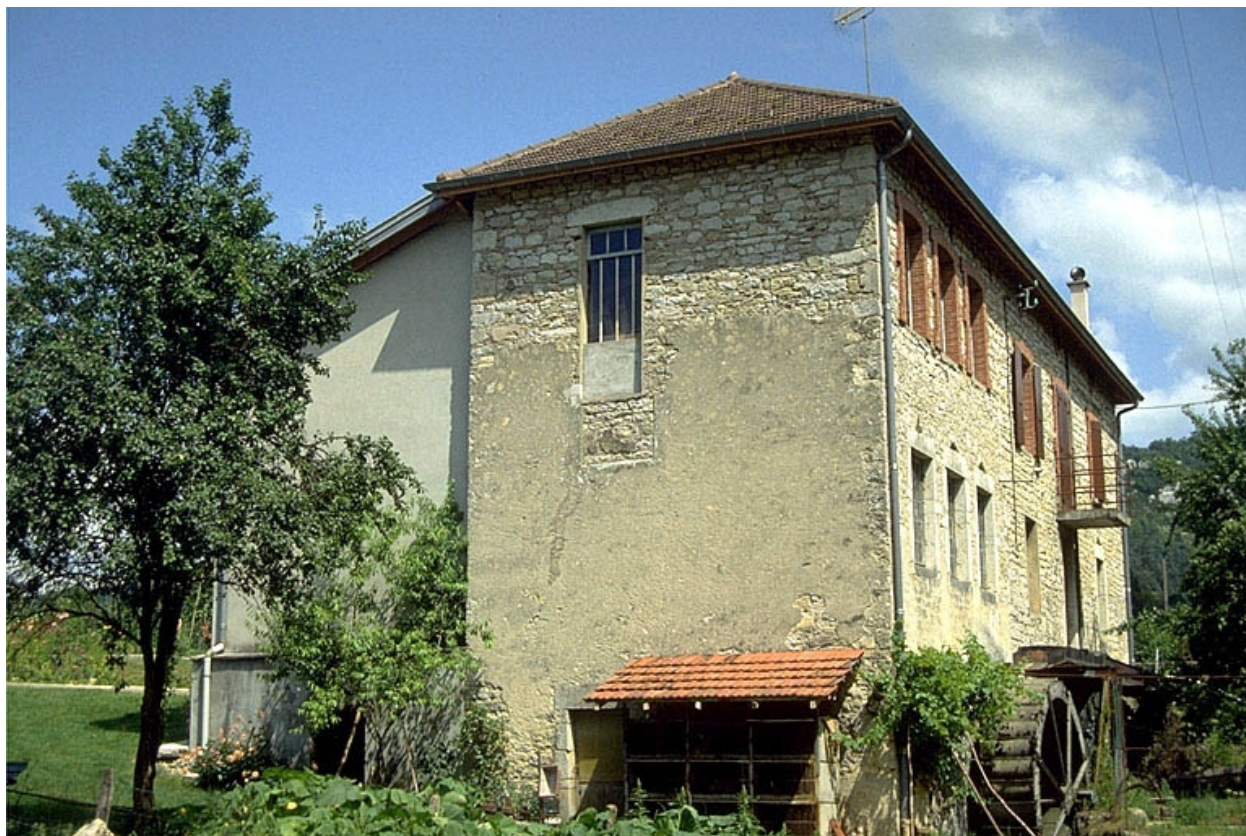
Façades postérieure et latérale droite.
