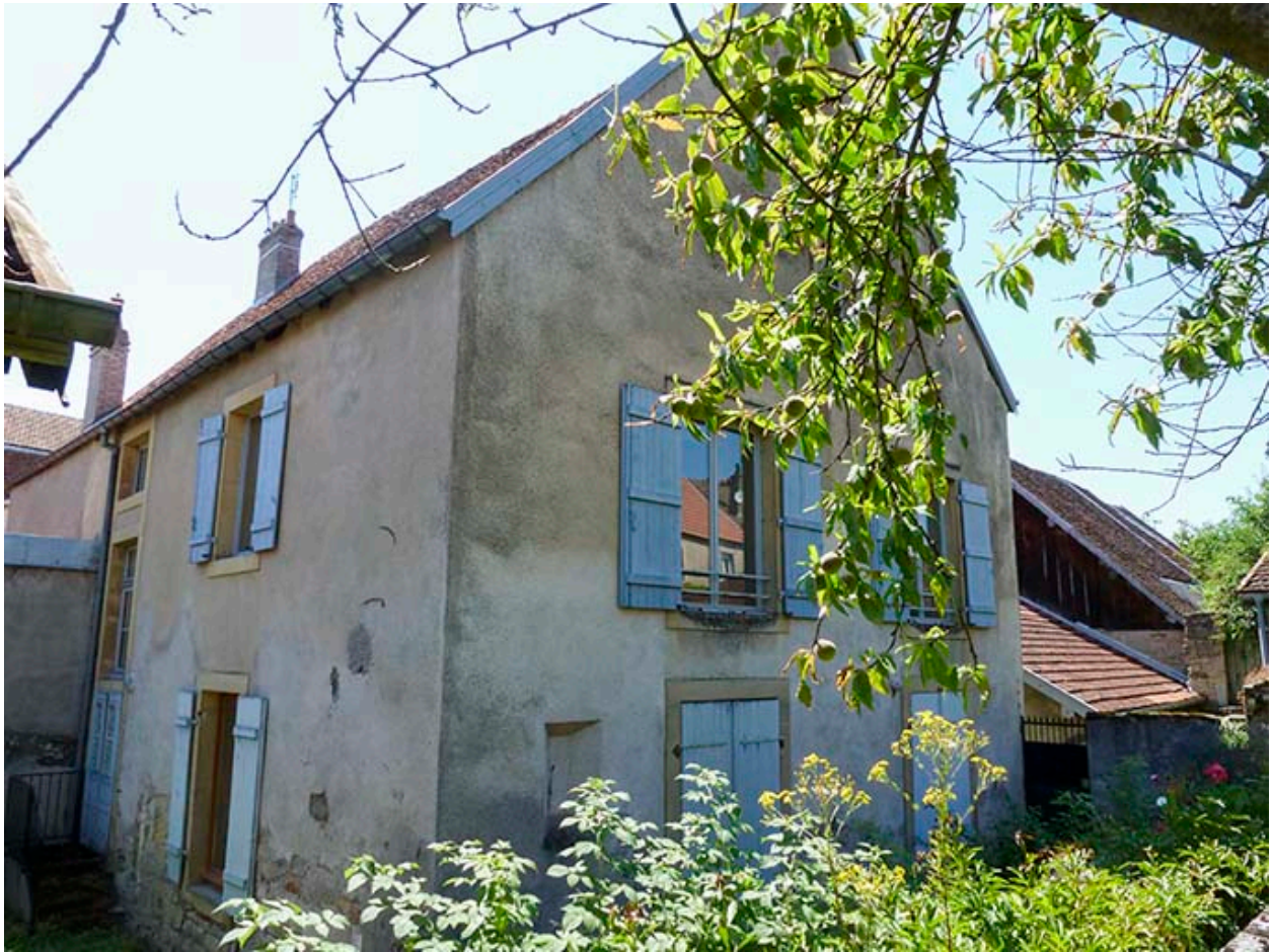
Façades postérieure et latérale droite.
